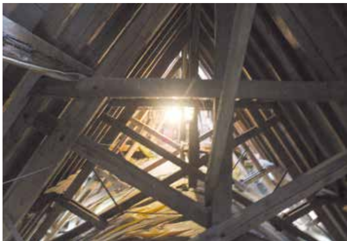
▲ Stara więźba nie była w najlepszym stanie, więc przed wymianą pokrycia niezbędne było wykonanie wielu prac ciesielskich
