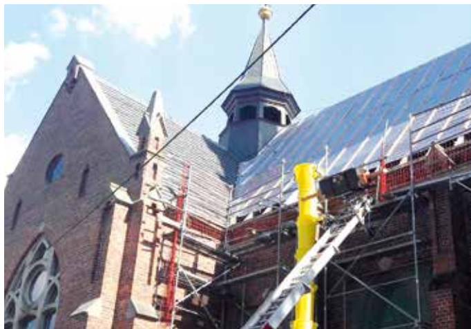
▲ Na mniejszej potaci widoczna jeszcze stara dachówka, na większej potaci – nowa folia i tacerie
