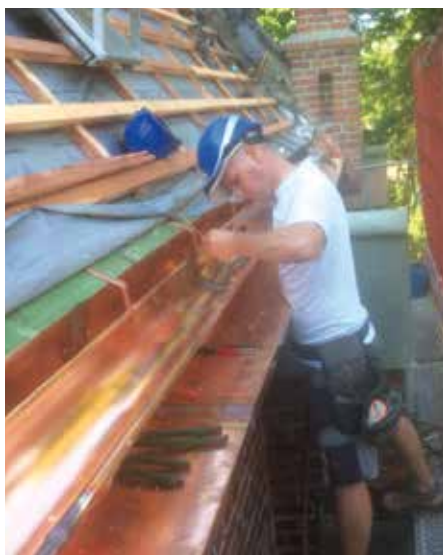
▲ Całość obróbek blacharskich została wykonana w miedzi
