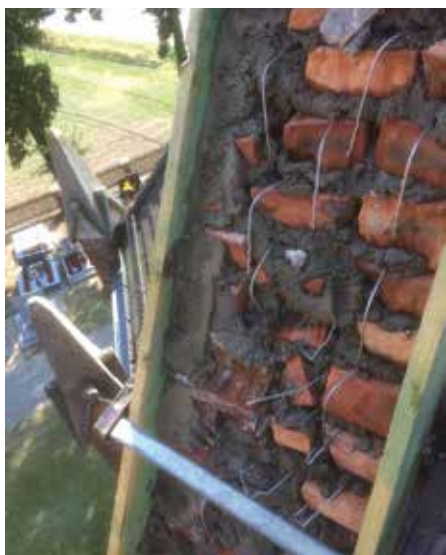
▲ Dekarze musieli wykonać również drobne prace murarskie ...
