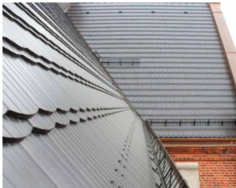
▲ Krycie w koronkę żłobkowaną karpiówką – jak w oryginalnym wykonaniu
