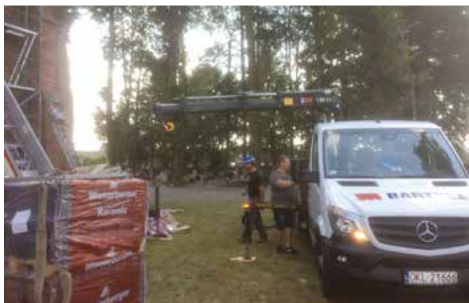
▲ Zamontowany na samochodzie dźwig dostarczał materiały na dach
