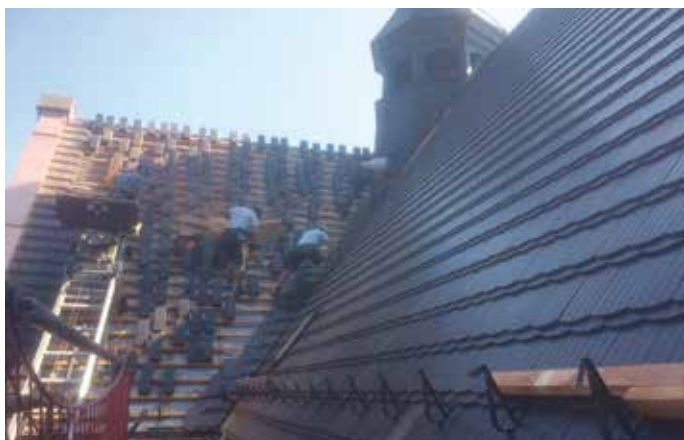
▲ Dach był bardzo stromy i wymagał użycia specjalistycznego sprzętu
